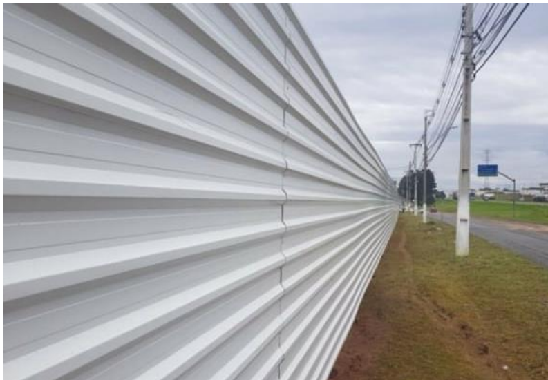
Imagem 17 – Tapume com telha metálica trapezoidal
