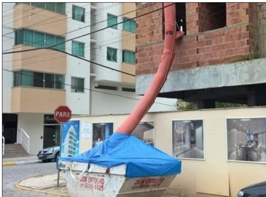
Imagem 24 – Retirada de entulhos com duto coletor
