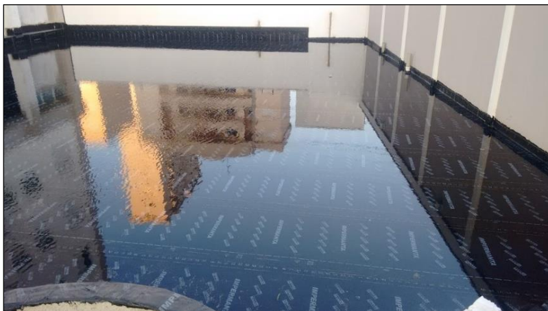
Imagem 29 – Exemplo de laje inundada para teste
