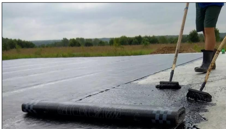
Imagem 25 – Aplicação de manta asfáltica – Fonte: Quartzolit
