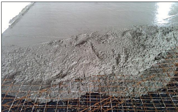
Imagem 30 – Execução de piso com tela anti-retração.
