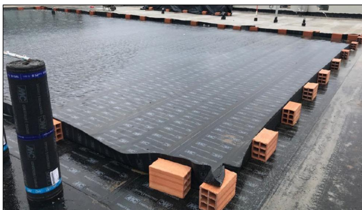
Imagem 28 – Exemplo de teste de Estanqueidade por setor
